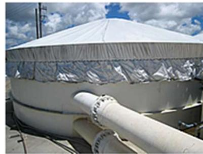
直径7M 深さ5M浄化槽
